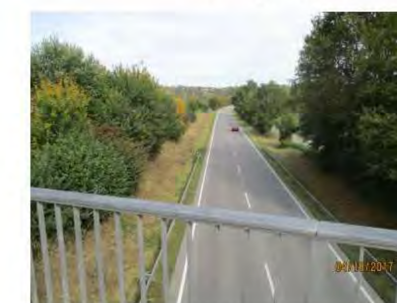
17. Brücke Laiz B 313
