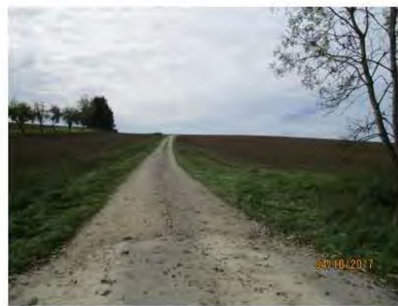
12. Südumgehung Krauchenwies - westlicher Teil
